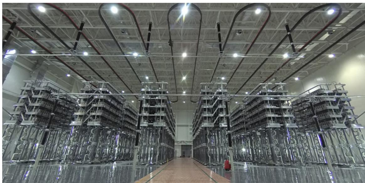
特高压柔直阀厅网架结构体系
