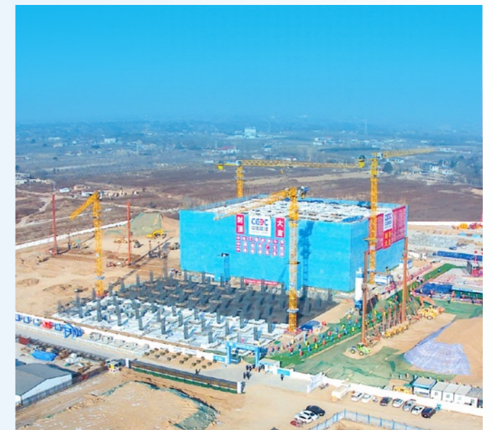
庆阳 A1 数据中心主体结构顺利封顶
