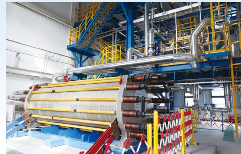
大型碱性电解水制氢机组稳态特性试验检测平台（8 兆瓦级）
