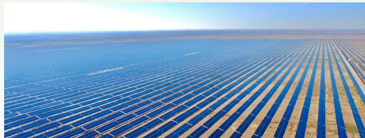
沙特拉比格300兆瓦光伏电站项目
