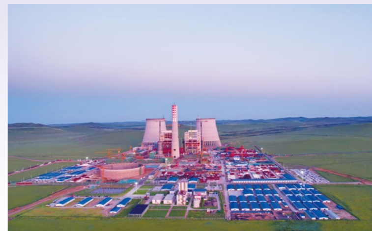
江苏能源乌拉盖2×1000兆瓦高效超超临界燃煤发电机组工程
