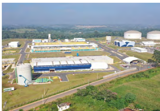
巴西圣诺伦索供水项目
