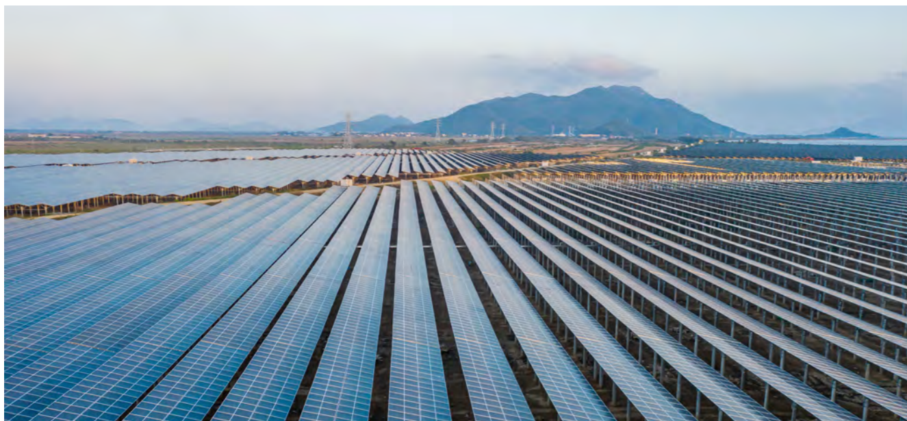
中国能建广东院投资建设的广东台山 500 兆瓦渔光互补项目，将光伏发电和渔业养殖有机结合起来，“上可发电、下可养殖”，实现了沿海滩涂资源的高效利用和生态开发。该项目年发电量达 5.43 亿千瓦时，可节省标煤约 19.3 万吨，减少碳排放量约 53.4 万吨。
