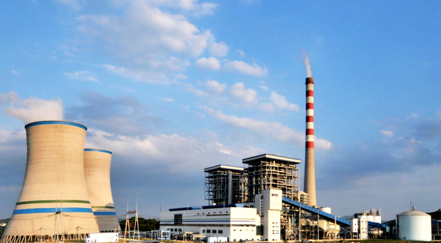
▲ 中国能建承建的国电宝庆电厂 2×600MW 建安总承包工程获鲁班奖
