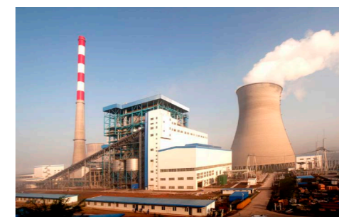
▲ 世界上单机容量最大的循环流化床锅炉环保机组工程——四川白马电厂600MW循环流化床锅炉示范工程
