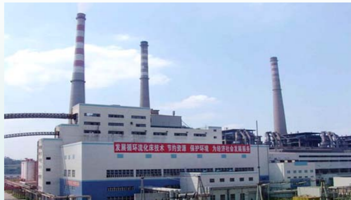
▲ 中电工程西南院设计的世界首台60万千瓦循环流化床机组工程——四川白马1×60万千瓦机组示范工程顺利通过试运行
