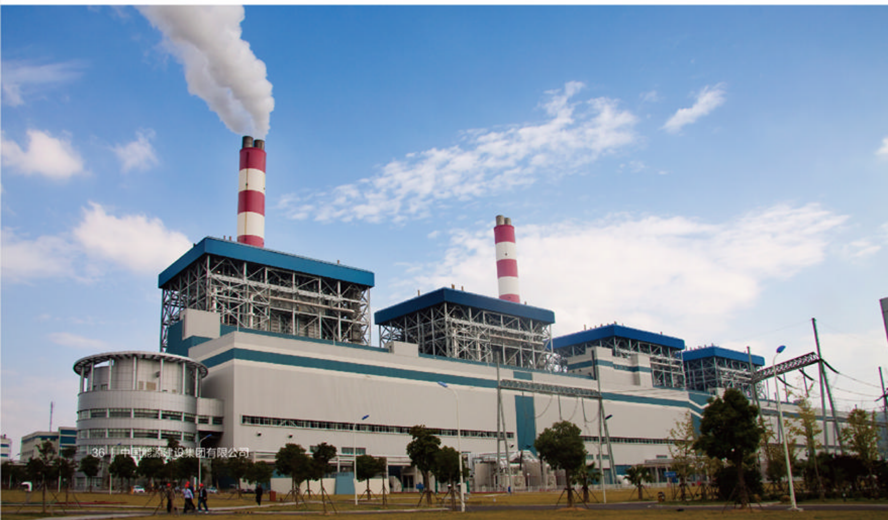
▼ 全国首台百万千瓦超超临界机组——华能玉环电厂（4×1000MW）
