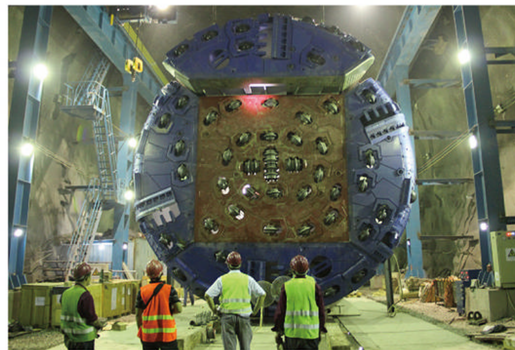
▲ 承建的巴基斯坦尼鲁姆 - 杰勒姆水电站是中国目前最大的海外水电工程
