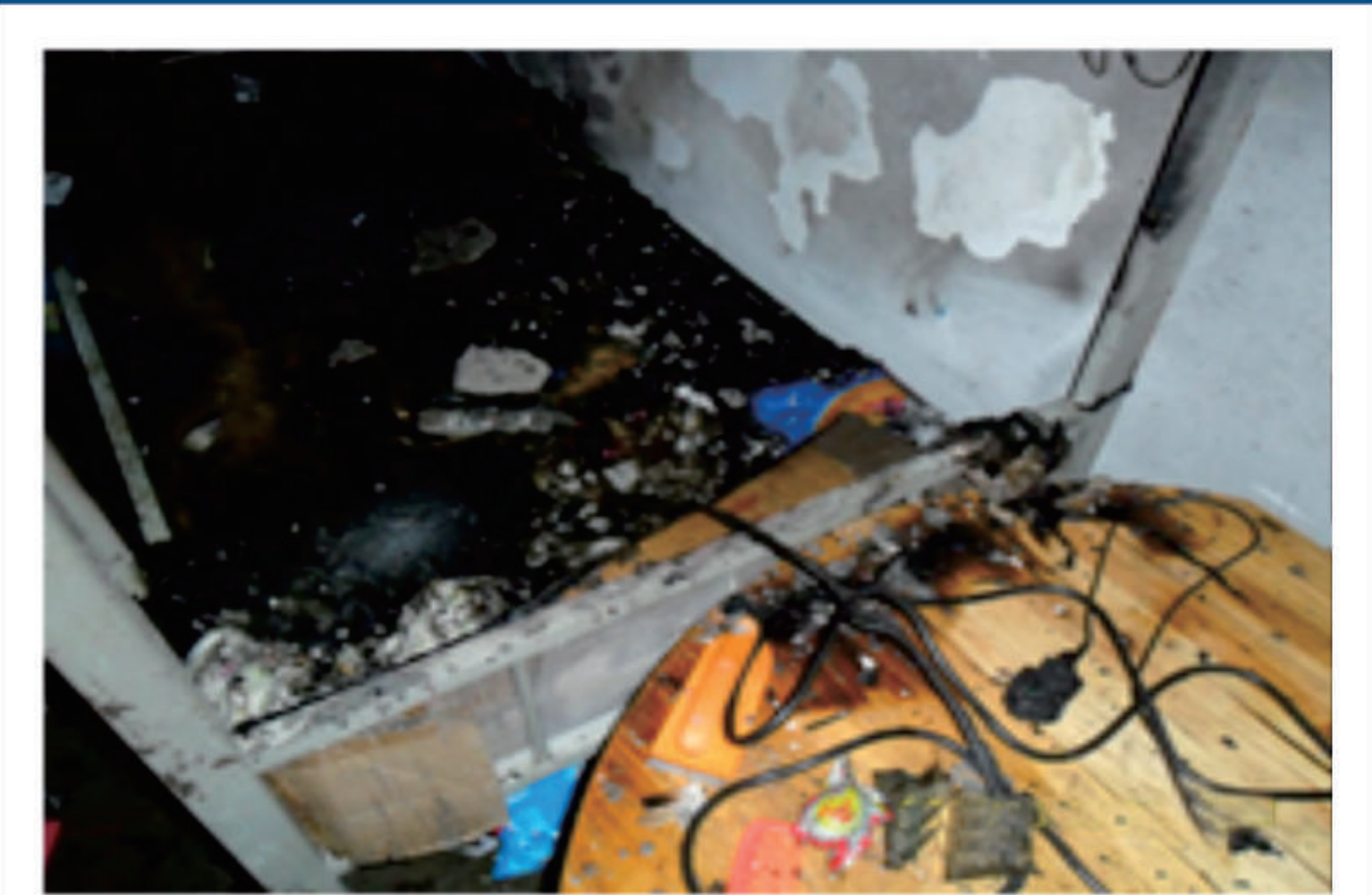
着火点周围的电线随意拉设
