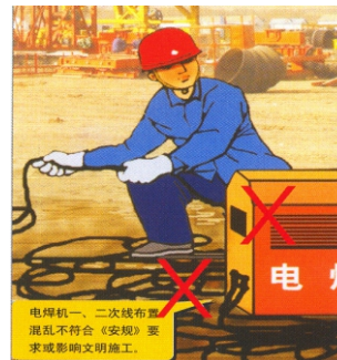
电焊机一、二次线布置混乱不符合《安规》要求或影响文明施工
